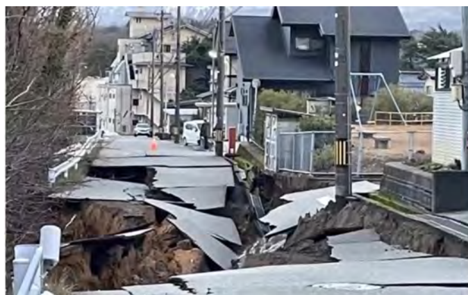
図2 小松市の道路に見られた被害
